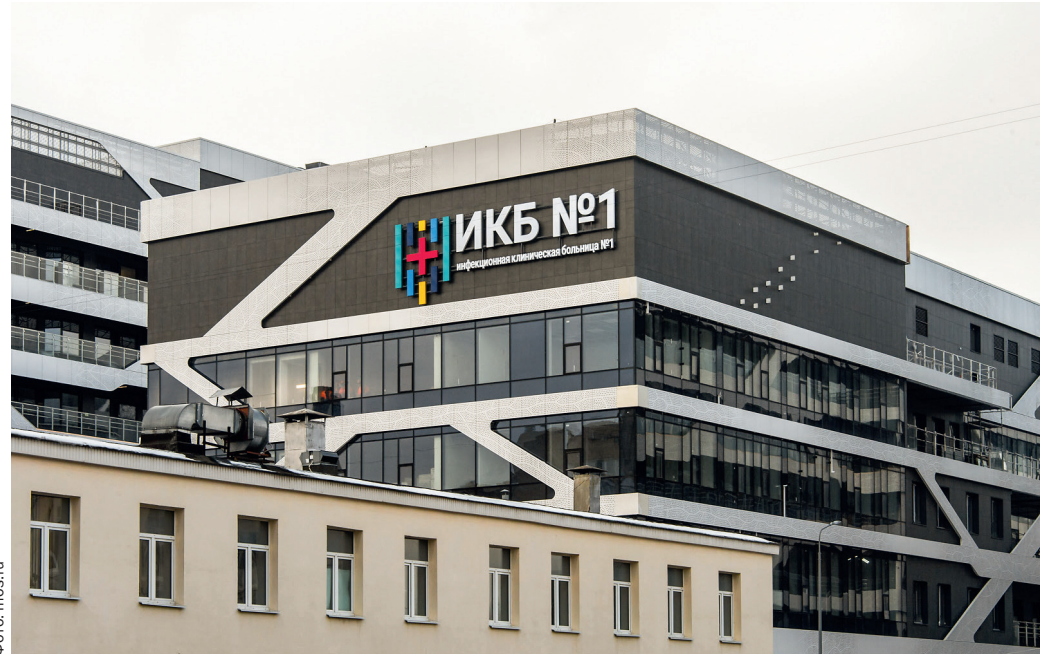
▲ В корпусах завершаются отделочные работы
